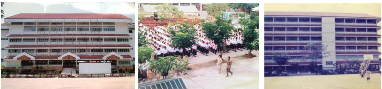
ภาพการก่อสร้างอาคารเรียนที่สองและสามของโรงเรียน
